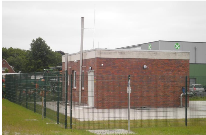
Pumpwerk „Dornumer Straße“
